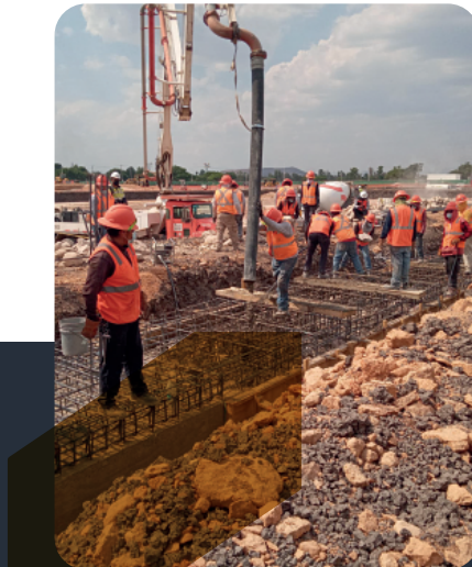
Cimentación Obra Civil
