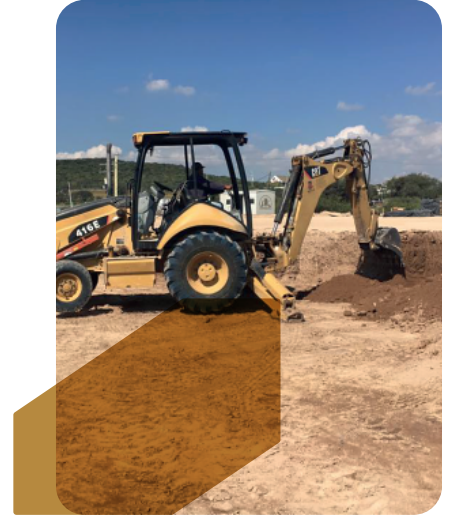
Terracerías Obra Civil
